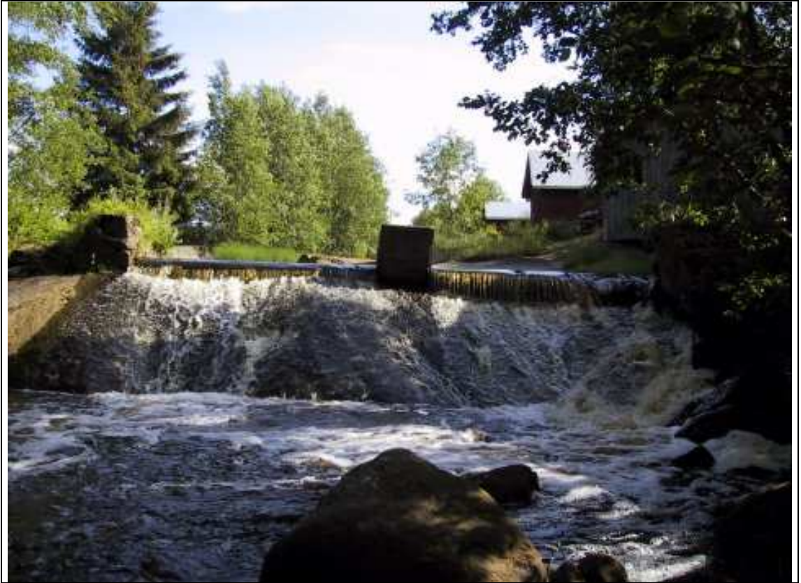
Kuva 18. Orismalan mylly, kohde 65. Kohde edustaa katoavaa kulttuuriympäristöä. Se on säilynyt sekä ulkoasultaan että sisätiloiltaan poikkeuksellisen alkuperäisenä. Kuvassa koski ja pato. Tiina Lehtisaari
