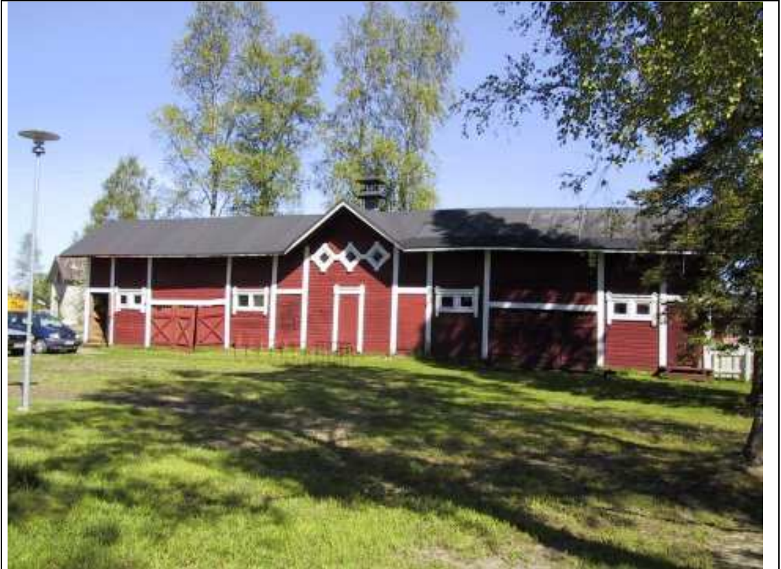
Kuva 14. Esimerkki Orismalan asemanseudun rakennuskannasta, kohde 28B kaksoisvahtituvan ulkorakennukset. Tyypillisiä asema-alueen ulkorakennuksia, jotka ovat säilyneet poikkeuksellisen hyvin alkuperäisessä asussaan. Tiina Lehtisaari
