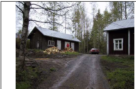
5. Myöhäinen, mäkitupa ulkorakennuksineen ( kohde N:o 15, T.Lehtisaaren inventointi)
